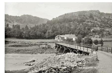
Denne Bjerkreimsbrua ble bygget i 1878, og rester etter disse brukarene kan enda sees like overfor nåværende bru fra 1922. Brua ble bygget for hestekjøretøyer og fikk godt rekkverk på sidene. Slett ikke rart at dette ble bygdas danseplass hvor ungdom og folk samlet seg. Men det har vært bruer over elva lenge før – den første ble bygget omkring 1615.
