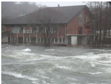
Store vannskader i underetasjen på bedehuset.
