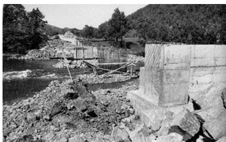
Bjerkreimbrua over Gjedlakleiva bygget i 1975.
