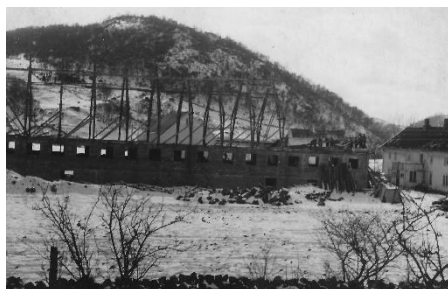
Den nye fjøsbygningen til Klaus (K.G.M.) Bjerkreim reist i 1954. Foto: Alf Gjedrem, han tok et foto fra samme vinkel for hvert sperr som ble reist.
